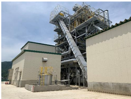
図5 2020年4月から稼働している舞鶴市内の木質バイオマス発電所
