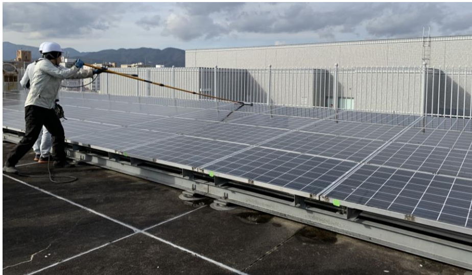
図10 京都府本庁舎2号館屋上に設置した太陽光パネルの洗浄作業の様子
