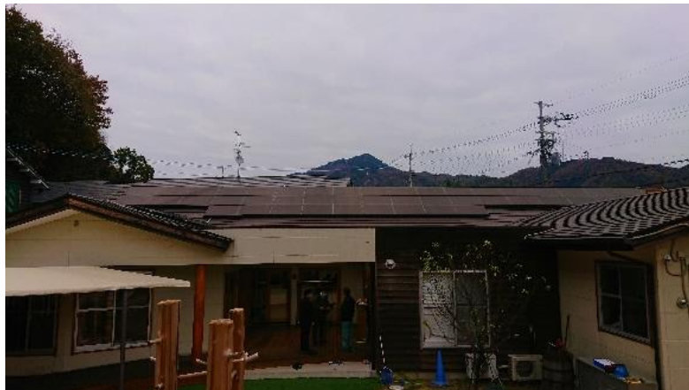
図8 市民協働により太陽光発電設備・蓄電池の導入による防災力向上を図る府内の施設
