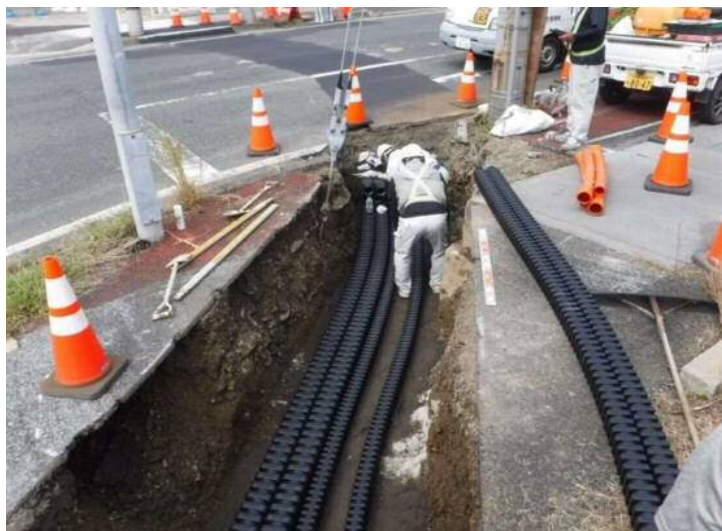
配管布設状況
