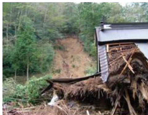
台風 23 号によるがけ崩れの状況 (舞鶴市下見谷地区)
