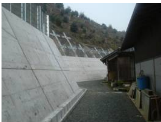
がけ崩れを防ぐ擁壁工
