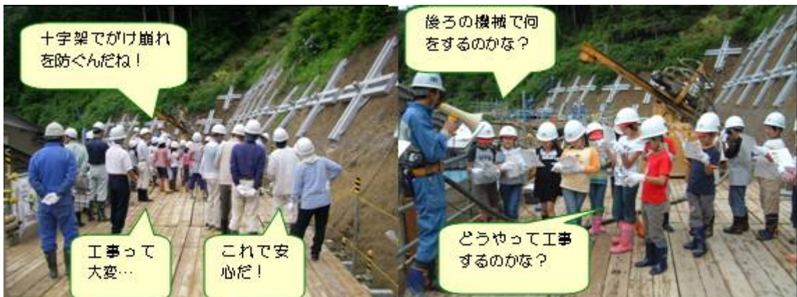
工事見学会の実施の状況（興味深げに工事を見学されています）
