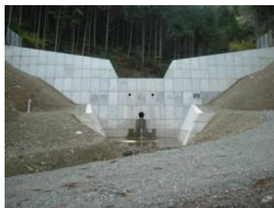
土石流を防ぐ堰堤工
