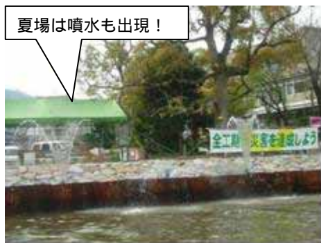
工事請負業からの様々な提案
