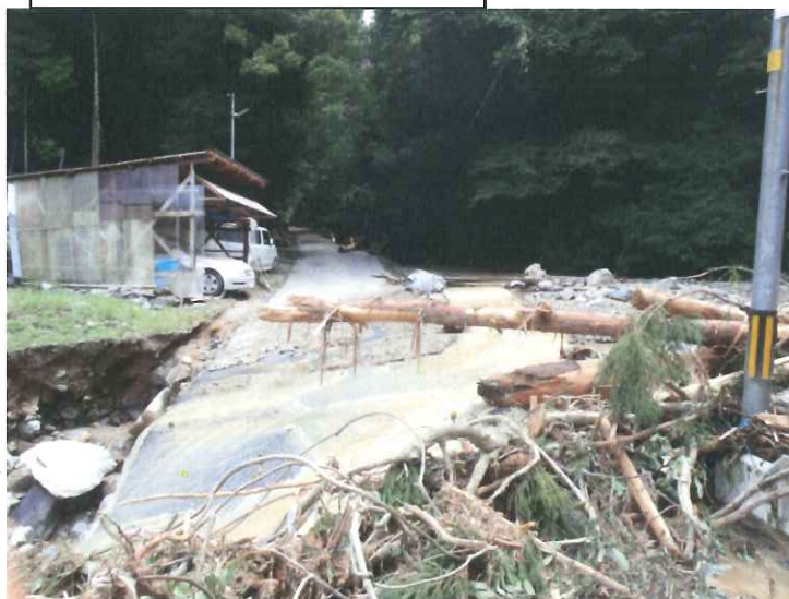
14日未明 土砂閉塞箇所
