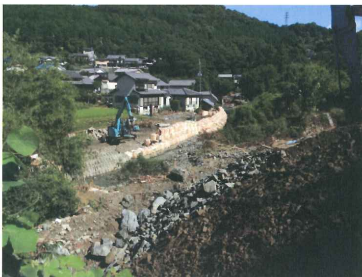
大型土のう設置状況(20日10時)
