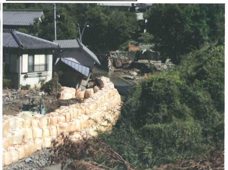
大型土のう設置状況(20日10時)
