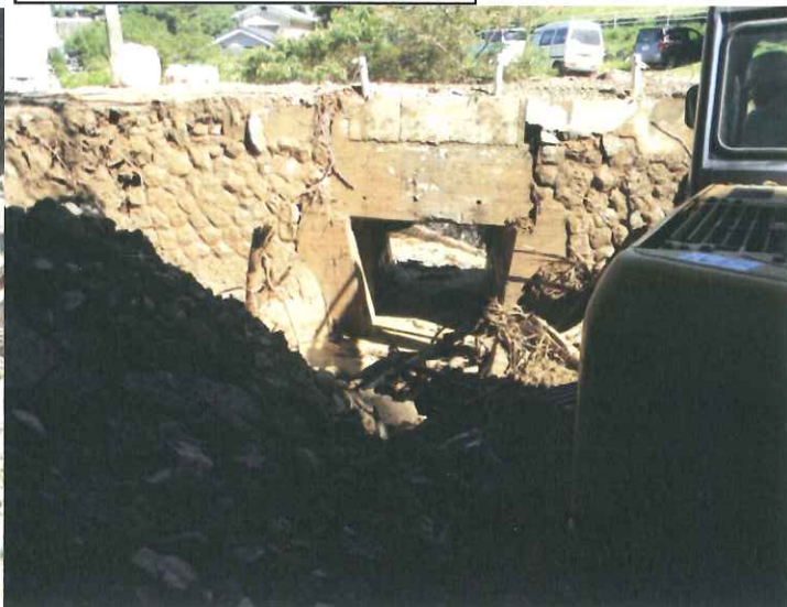
土砂撤去状況(20日10時)
