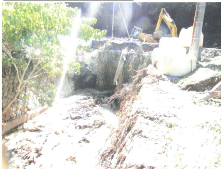
土砂撤去状況(20日10時)
