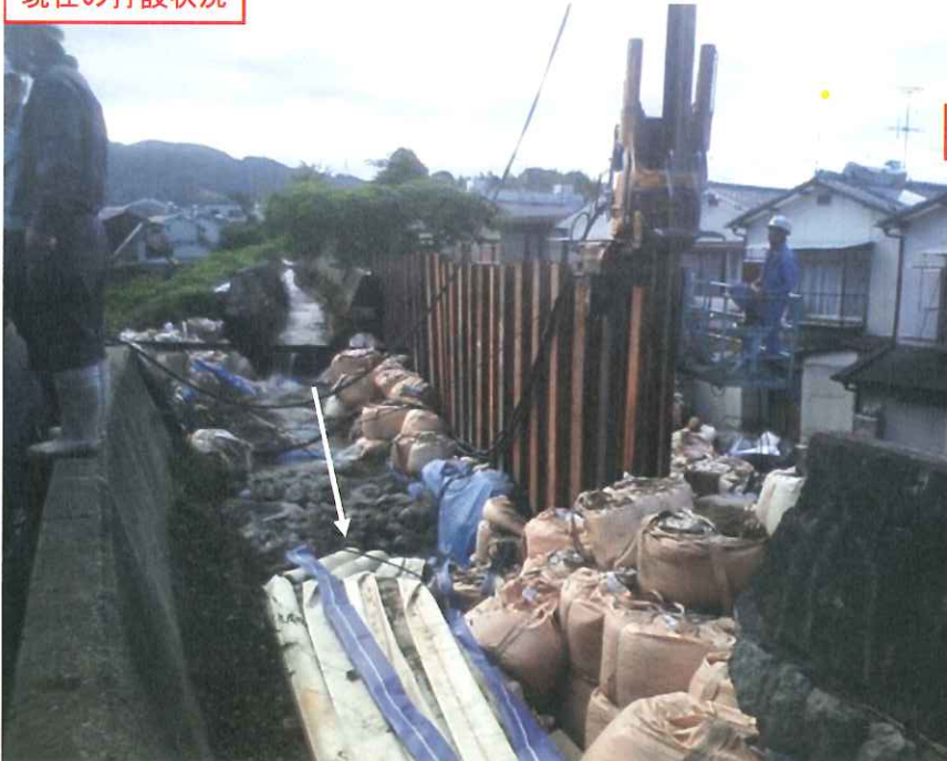
現在の打設状況
