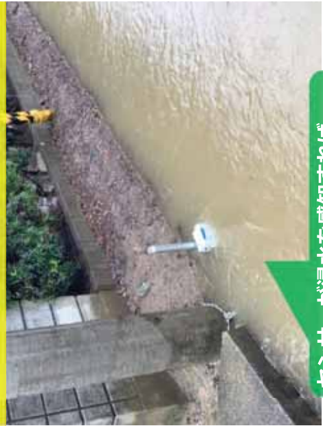
観音寺に設置の浸水センサー
