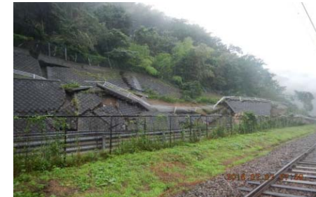
まいづるしまぐら ■国道27号(舞鶴市真倉) における法面崩壊
