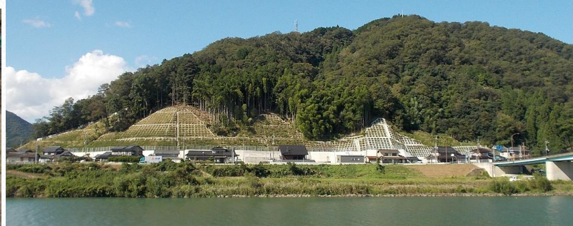
地頭：急傾斜地崩壊対策事業（舞鶴市）
