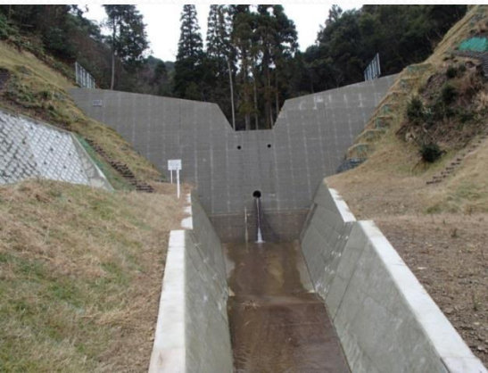
見行谷川：通常砂防事業（伊根町）
