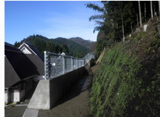
久多：急傾斜地崩壊対策事業（京都市）
