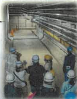
地下通路 『管廊』
