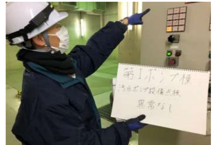
木津川上流浄化センター 場内調査訓練
