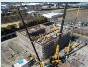
1Fコンクリート打設完了 R3.1
