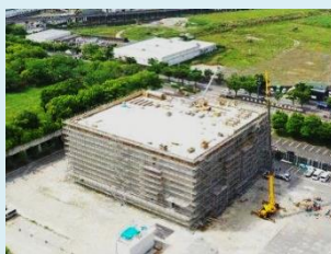
屋上コンクリート打設完了 R3.5
