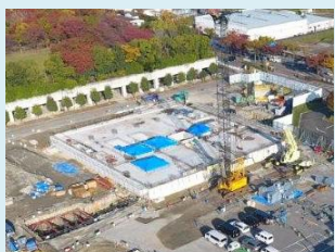
土木工事完成 R2.11
