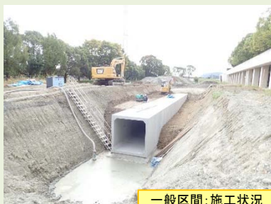
一般区間:施工状況
