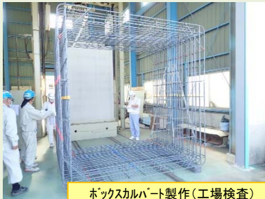
ボックスカルバート製作(工場検査)
