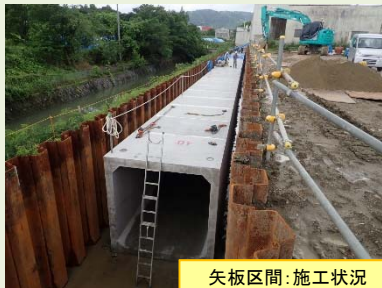
矢板区間:施工状況
