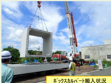
ボックスカルバート搬入状況
