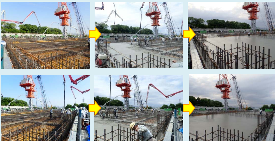
▲コンクリート打設前
