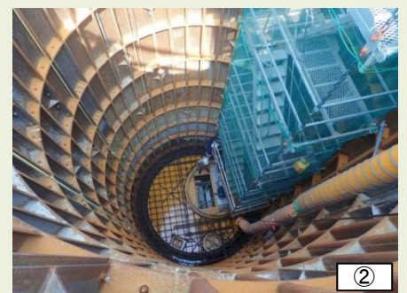
▲マンホール工事 施工状況
