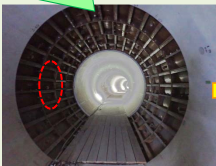
▲南幹線本管(工事着手前)
