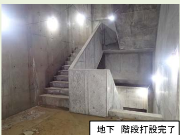
地下 階段打設完了
