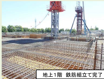
地上1階 鉄筋組立て完了
