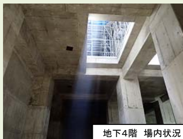
地下4階 場内状況
