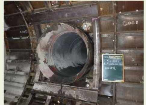
▲ 南幹線本管接続完了
