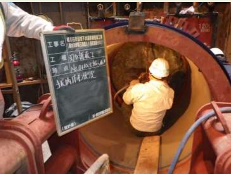
▲ 作業員による掘削状況
