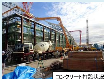
コンクリート打設状況
