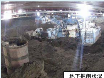
地下掘削状況
