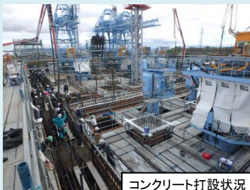
コンクリート打設状況
