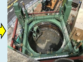
圧入装置(写真緑色)を設置し、圧入開始
