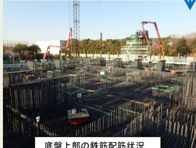
底盤上部の鉄筋配筋状況
