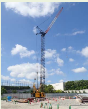
80t吊クローラークレーン
