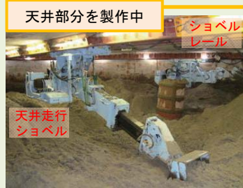
作業室内掘削状況(別工事)
