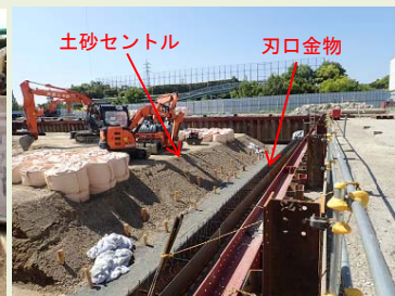
刃口金物設置状況
