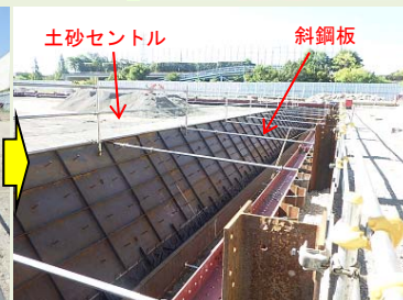
斜鋼板設置状況
