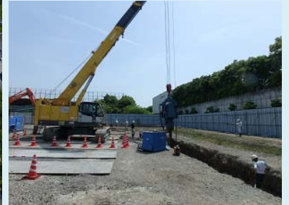
仮設囲い鋼矢板打設中
