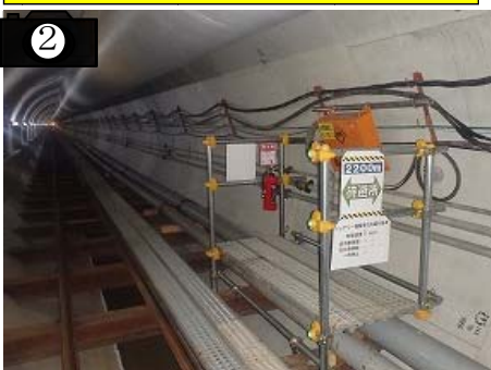
トンネル内部の状況
