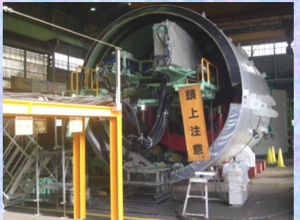
シールドマシンの工場の状況②
