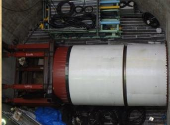
反力材や鋼製リングをトンネル掘削機の後方に設置し、反力を取りながら、掘進を進めています。
