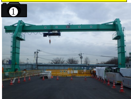
門型クレーンの設置状況
