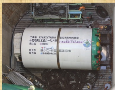
発進立坑内（掘削機）（拡大）
