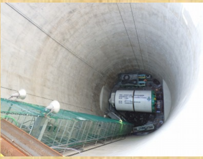
発進立坑内（掘削機）
