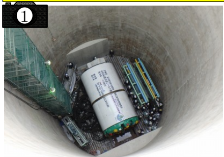
発進立坑内の状況 (掘削開始)
