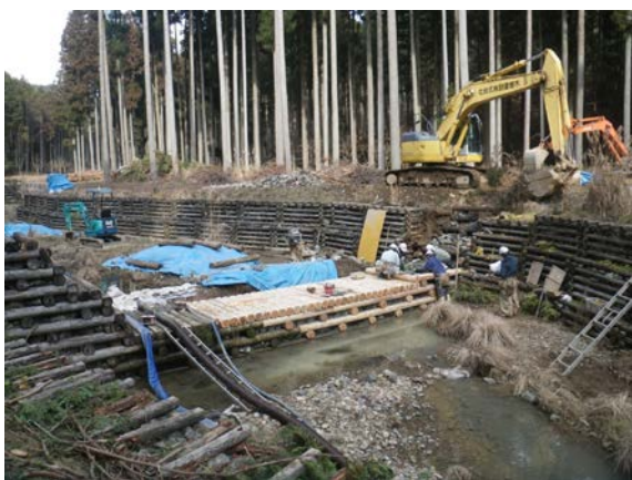
5. 組立・中詰（中詰石材は再利用）
