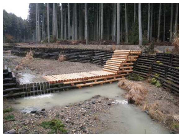
6. 部材交換完了
