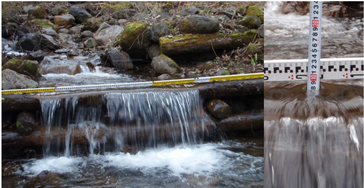
図-3 スギ材を用いた治山ダムの部材の摩耗事例（ラムダ型：施工後9.5年経過）
