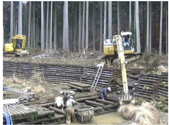
2. 木部材、中詰石材の撤去
