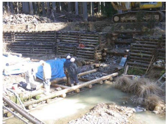
4. 組立・中詰（中詰石材は再利用）
