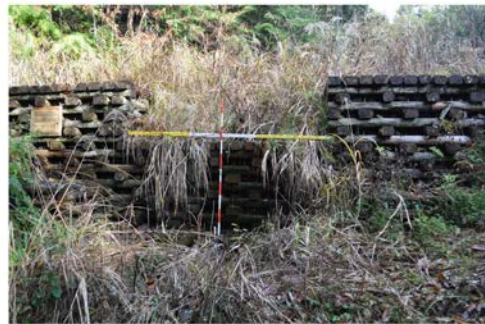
構造物の設置状況 (全景)
