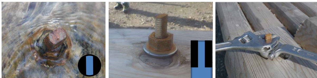
図-26 木製部材の交換時に、さび付いたボルトを片側から容易に緩めることができるようにボルトの頭部に突起を付けるよう工夫した事例
