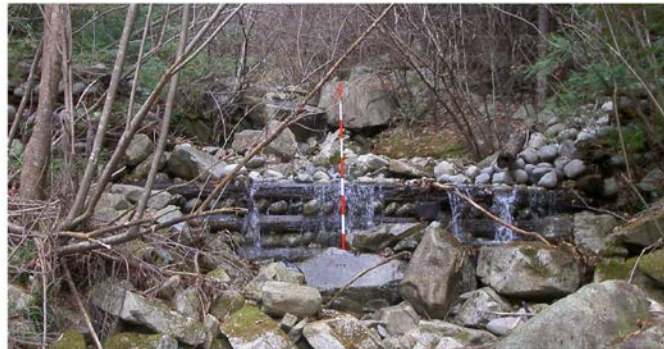
構造物の設置状況 (全景)
