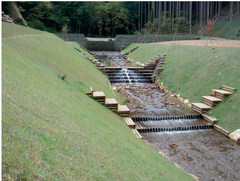
木製治山構造物の例
