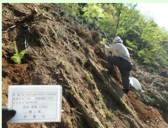
植栽状況：傾斜が40°を超える斜面は作業効率が著しく落ちるため再生林に不向き
