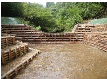
木製治山ダム
