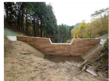
木製残存型枠
