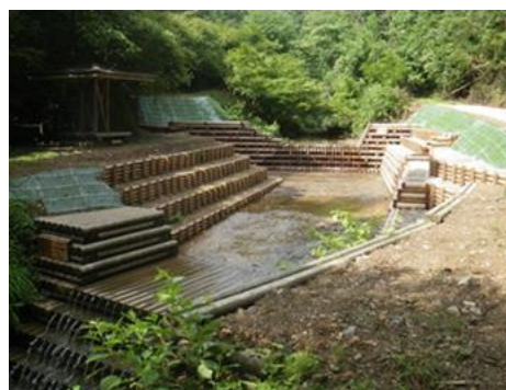
舞鶴市鹿原 木製治山ダム
