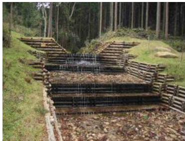
木製治山ダム
