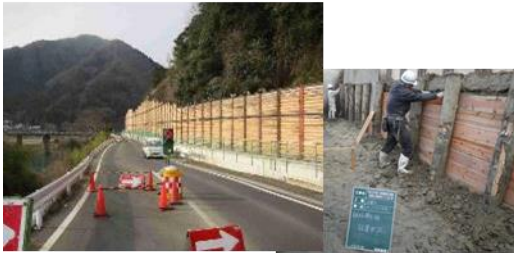
木製仮設防護柵・仮設土留め工
