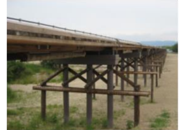
橋梁工（上津屋橋）
