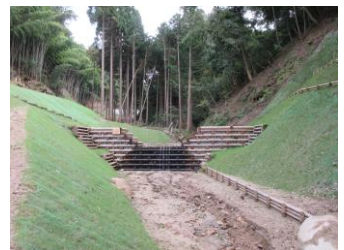
木製治山ダム
