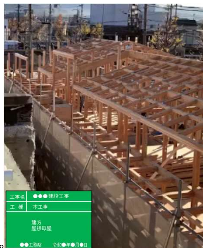
※施工中の写真(引き)
