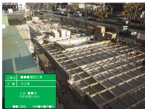
※施工中の写真(引き)
