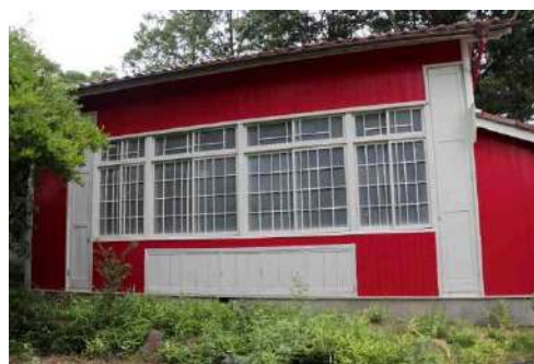
修繕工事が完了した「山のアトリエ」
