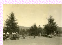
室戸台風の復旧作業
