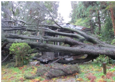
写真4 2017年 台風21号被害
