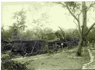
写真 2 室戸台風被害
