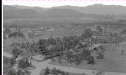
造成中の植物園
