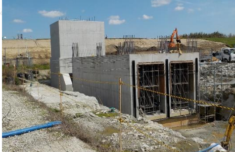
排水機場下部工(水槽)施工状況
