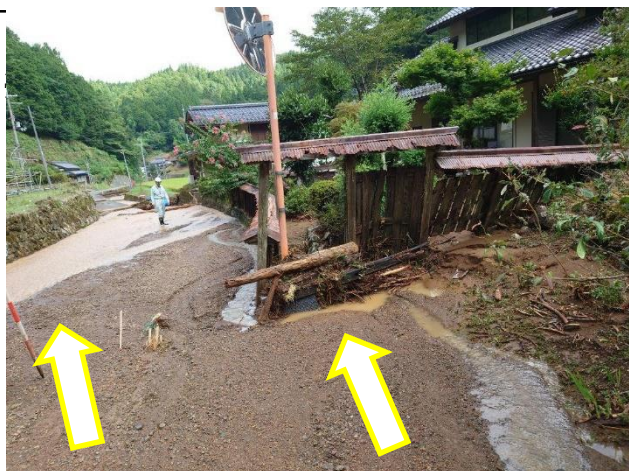
人家・府道被災状況
