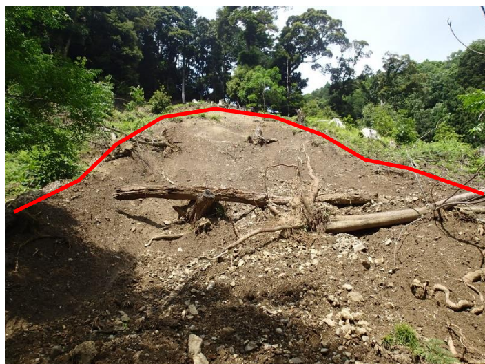
山腹崩壊状況
