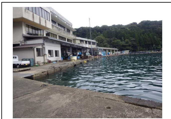
大浦第1岸壁 全景
