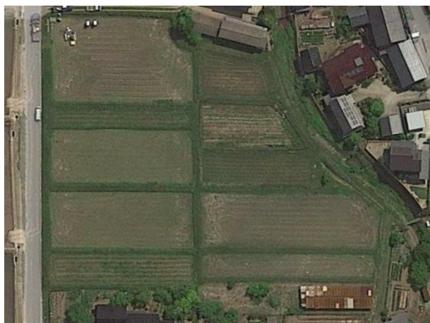
※写真①：着工前
