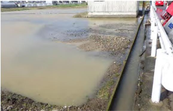
市道に埋設された送水管が損傷・漏水し、隣接ほ場が冠水、道路が陥没し、早急な改修が必要となりました。
