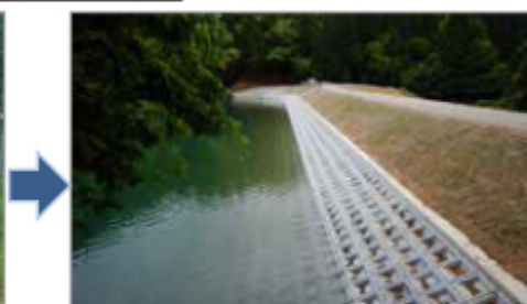
堤体を補強し、地震時の安定性を確保 ▲
