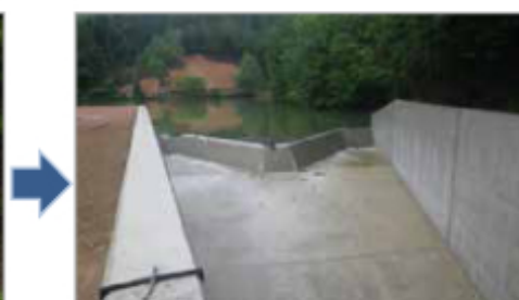
洪水吐を改修し、大雨時にも安全な排水を実現 ▲
