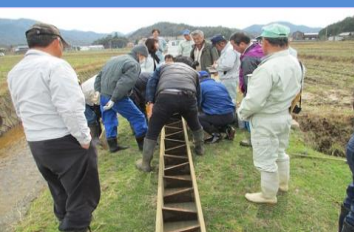
地元直営で 水田魚道設置
