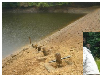
木製取水施設
