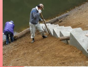
接続部の付き固め
