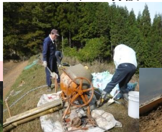
コンクリート打設
