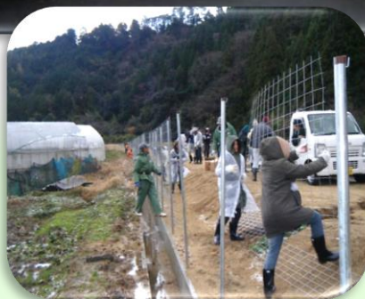
獣害防止柵の設置
