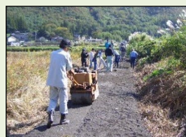
未舗装農道の舗装
