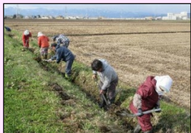
水路の泥上げ
