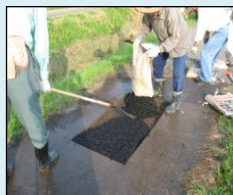
農道の部分補修
