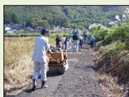
未舗装農道の舗装
