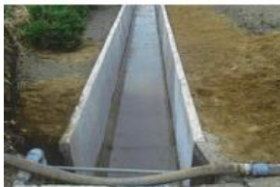
排水路の補修・更新等
