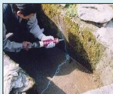
ひび割れの補修
