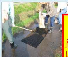
農道の部分補修
