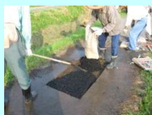
農道の部分補修
