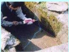
水路のひび割れ補修
