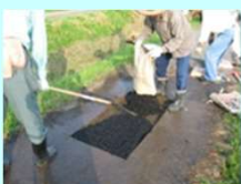
農道の部分補修
