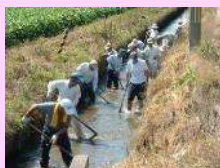
水路の泥上げ
