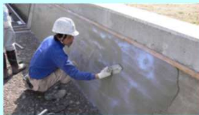
老朽化した水路壁のコーティング
